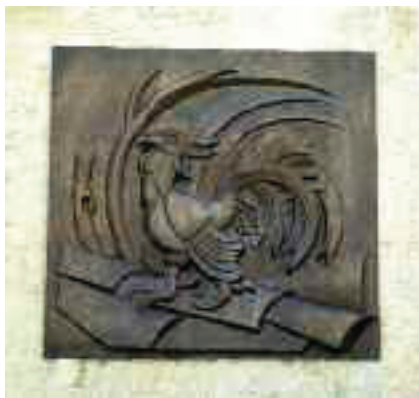
Un particolare all'esterno di Casa Depero a Rovereto prima e dopo il restauro
